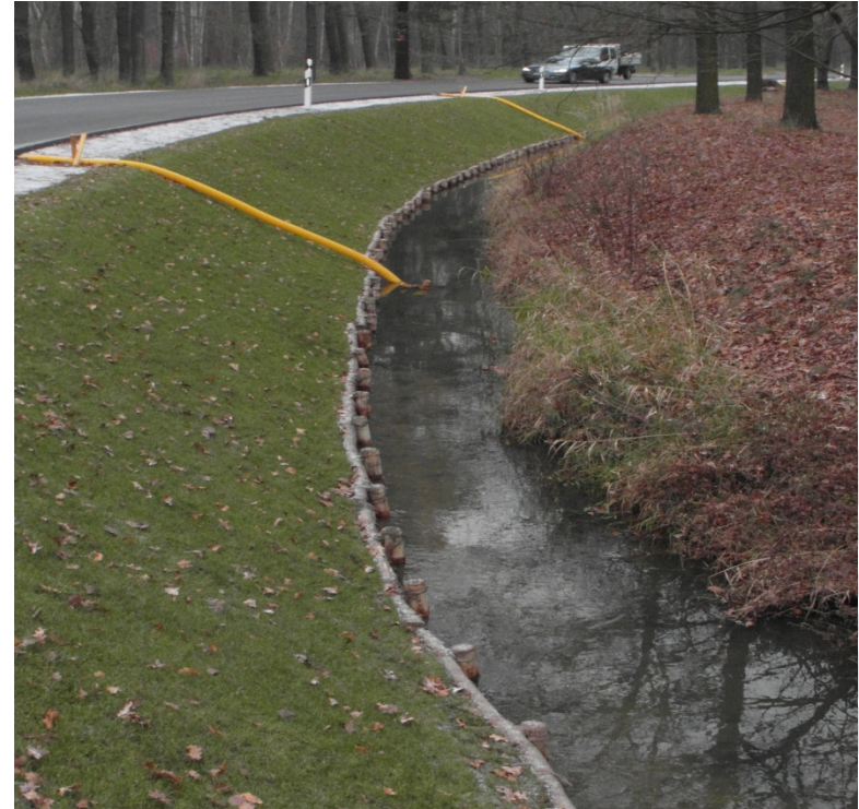
Fertigstellung der neuen Böschung
