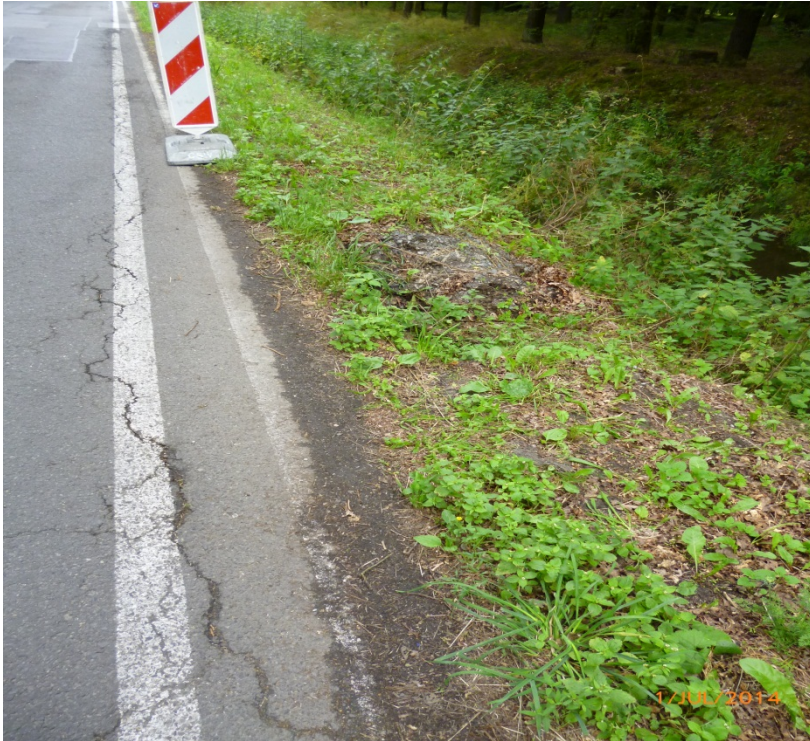
vor Beginn der Maßnahme
