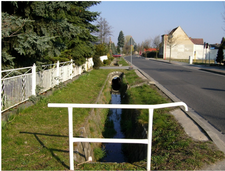
Abrutschende Straßenböschung in den Weizenackergraben
