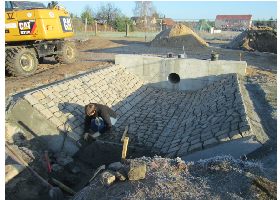
Einlaufbauwerk im Bau
