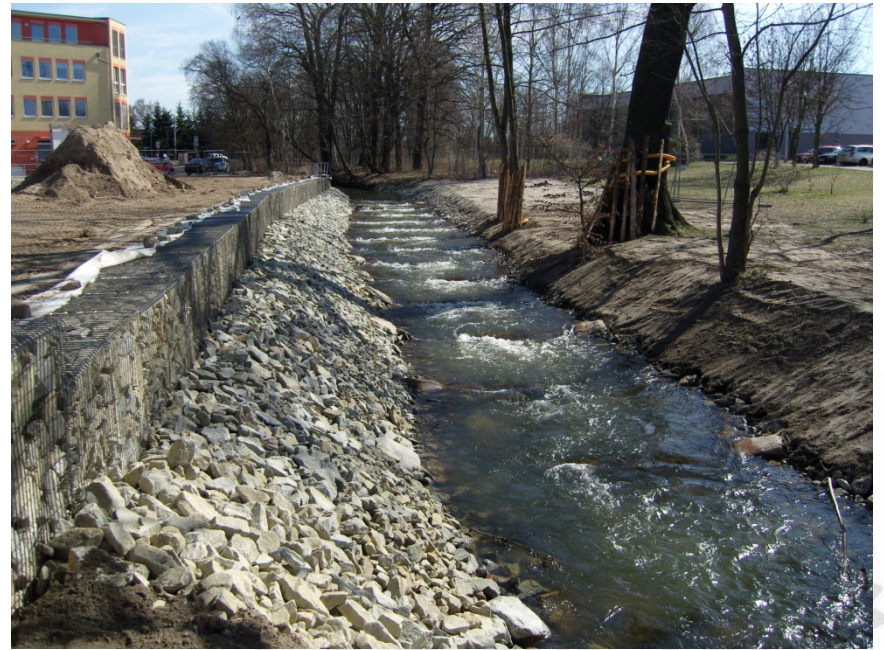
Neubau der Sohlgleite
