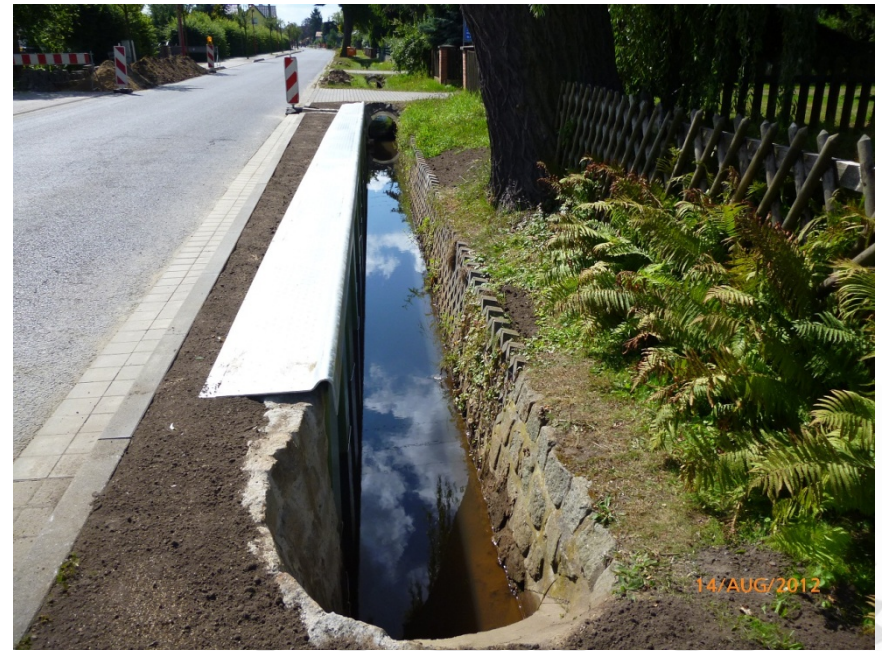
Böschungssicherung Weizenackergraben
