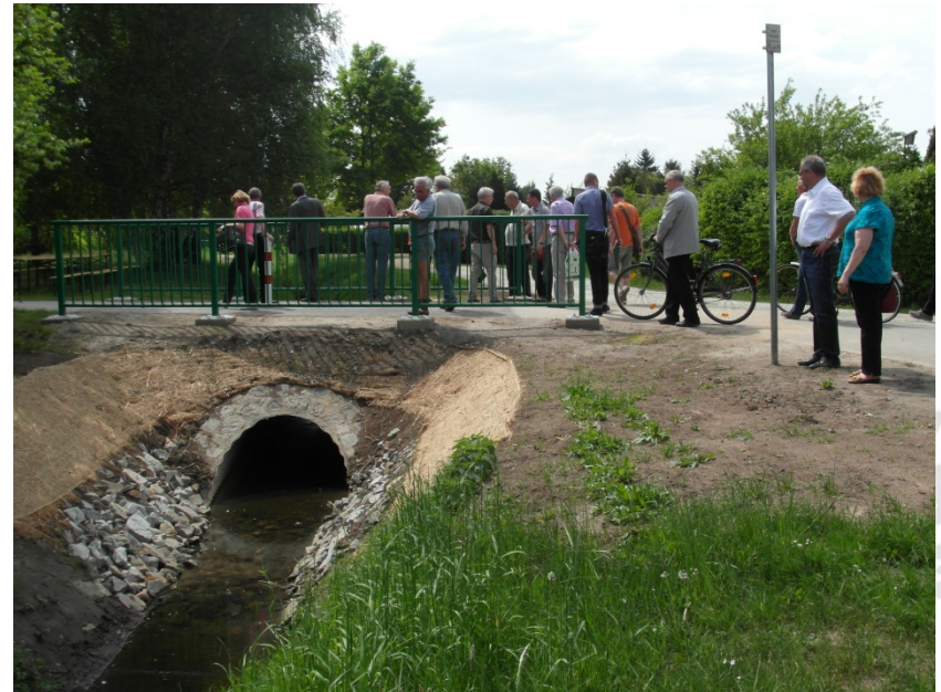
Neubau eines Durchlasses
