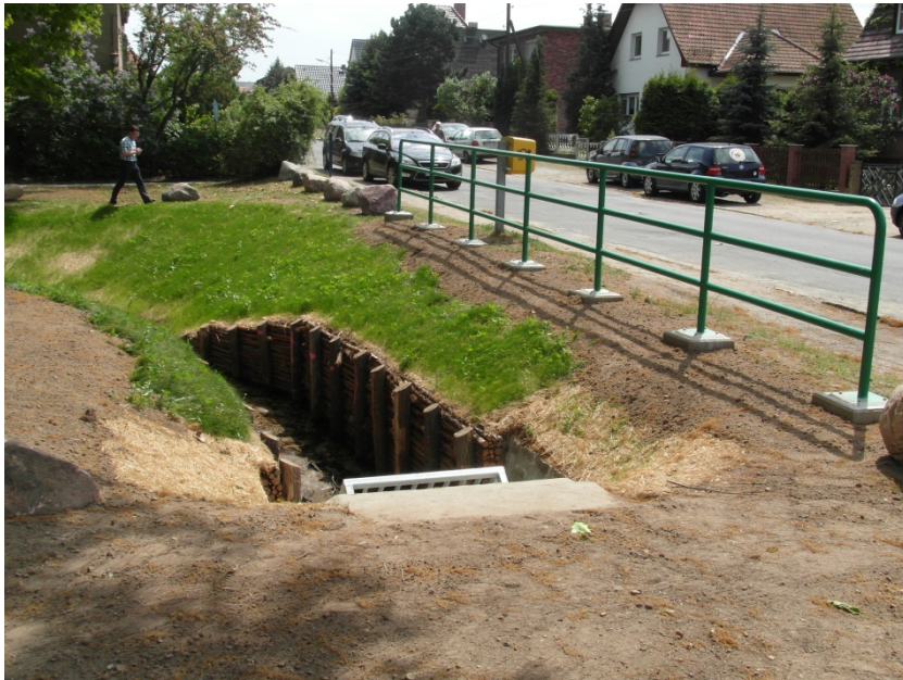
Herstellung des offenen Grabens
