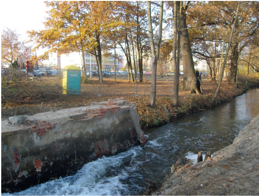
Priorgraben vor der Sanierung
