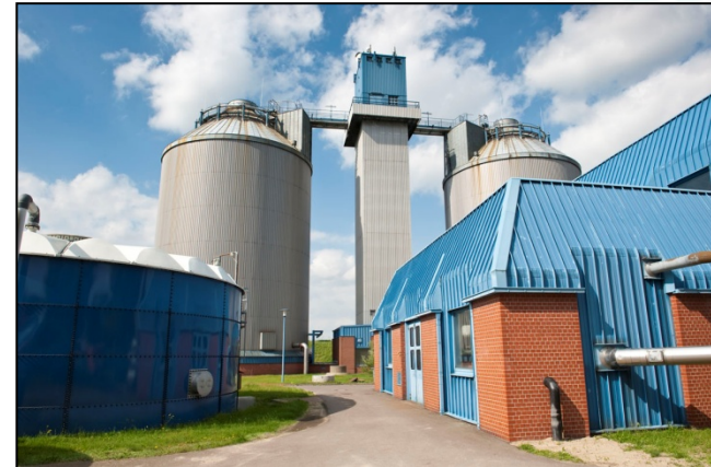
Die Kläranlage Cottbus
