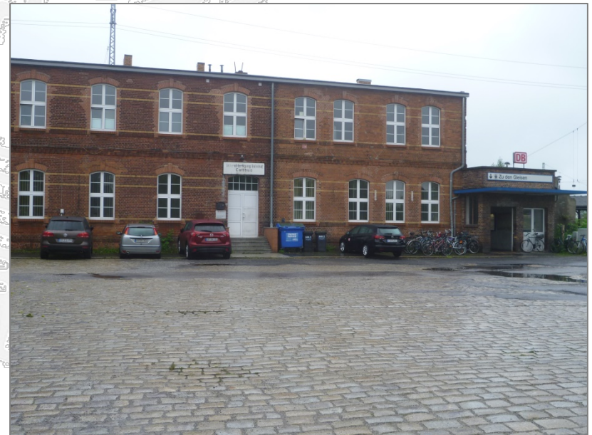
Bild: Blick nach Süden, Gebäude am Ende Güterzufuhrstraße (Güterzufuhrstraße 8)
