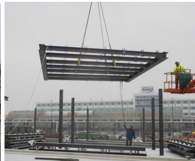
Dach 2 - Montage Querträge
