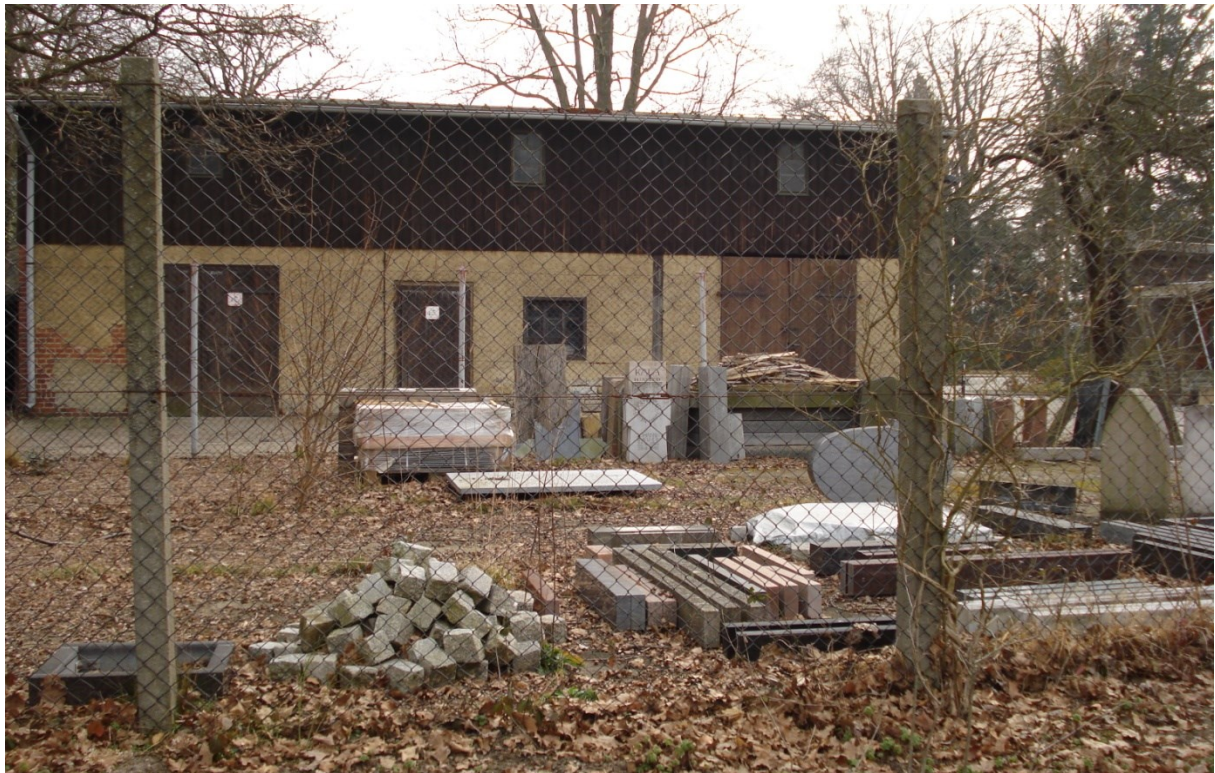
Umbau zu Parkstellflächen für Transporter und PKW
