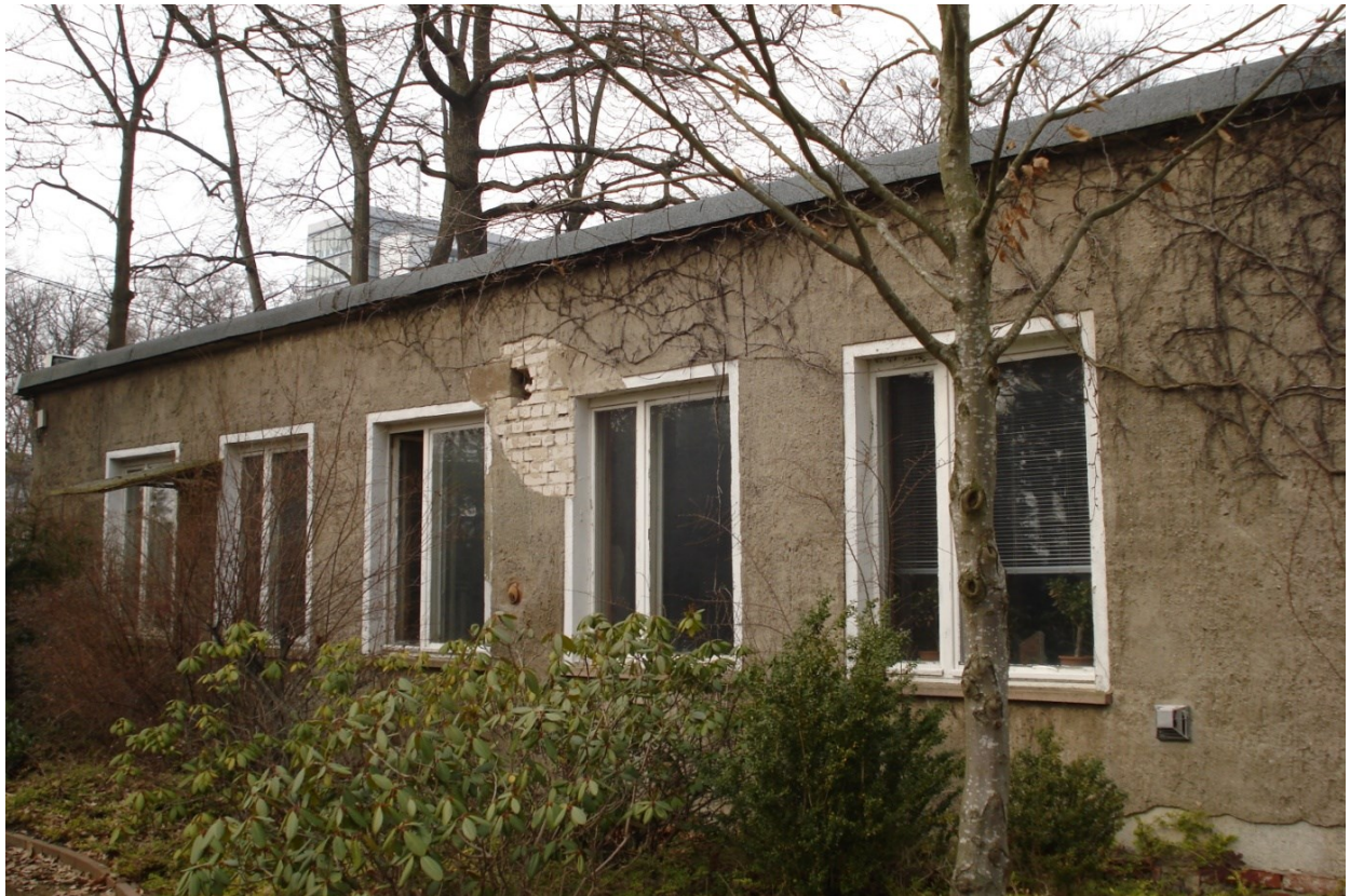
Umbau von Steinmetzwerkstatt zur Tischlerei, Sanierung Außenputz
