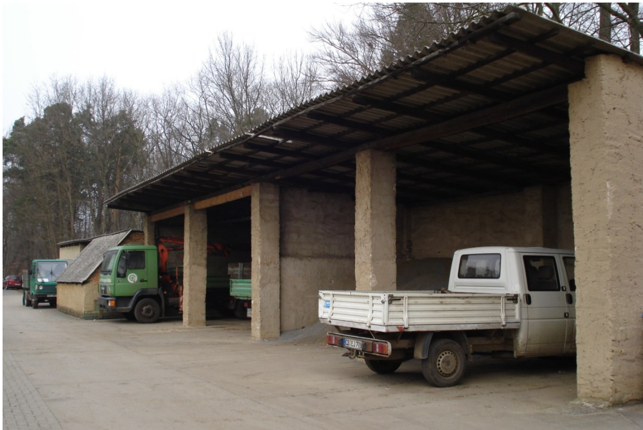
ungeordnete Bausubstanz mit Asbestabdeckung , Neubau Mittelgarage
