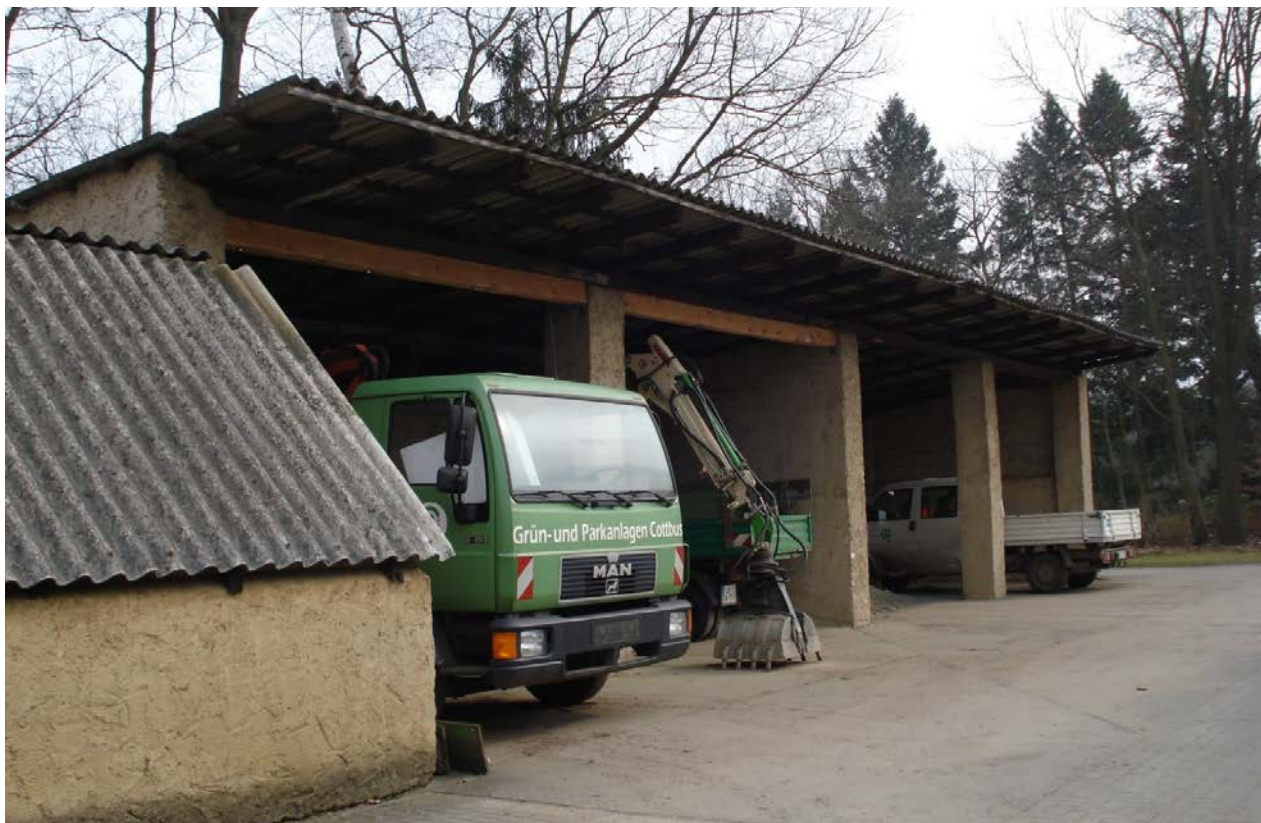
ungeordnete Bausubstanz mit Asbestabdeckung , Neubau Mittelgarage
