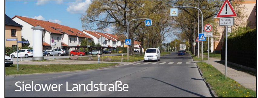
Sielower Landstraße Fahrbahnoberflächenanierung bzw. grundhafte Erneuerung der Fahrbahn
