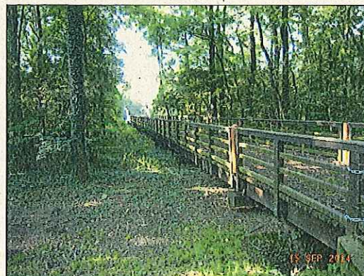
Abb. 05: Ansicht Vorlandbrücke Nordost
