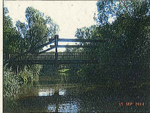
Abb. 02: Ansicht Strombrücke Unterstrom
