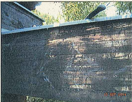
Abb. 32: Hängewerk, oben links, BSH gerissen
