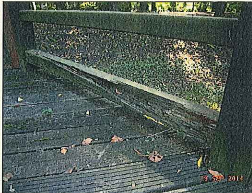
Abb. 12: Geländer Fußholm angefault
