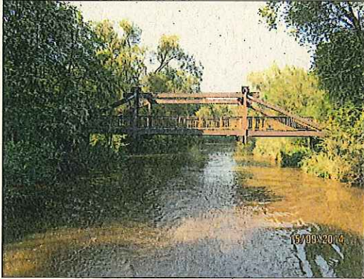
Abb. 01: Ansicht Strombrücke Oberstrom
