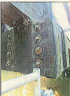
Abb. 40: Hängewerk, Querträger hinten, links 1 Mutter fehlt
