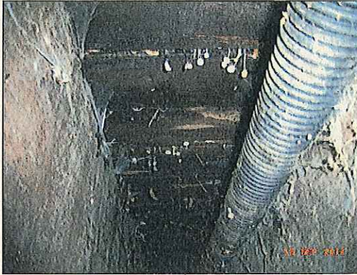
Abb. 30: Bohlenbelag durchfeuchtet & Pilzbefall
