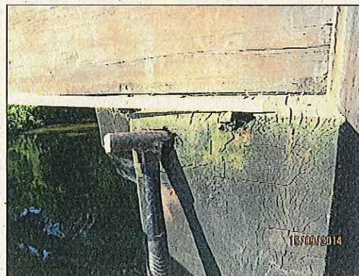
Abb. 39: Hängewerk, Querträger BSH gerissen Hirnholz mit Innenfäule
