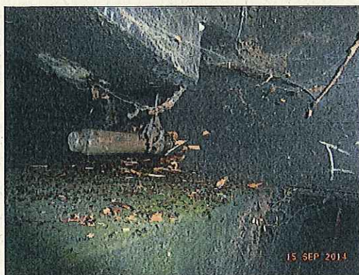
Abb. 44: Hängewerk, Längsträger BSH mit Innenfäule
