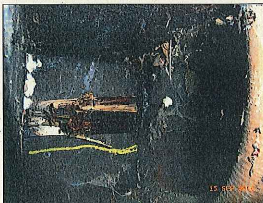
Abb. 20: Feld 12 rechts, BSH – Binder, Hirnholz mit Innenfäule
