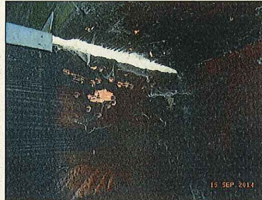
Abb. 37: Hängewerk oben rechts, Anschluss Querträger Myzelen sichtbar
