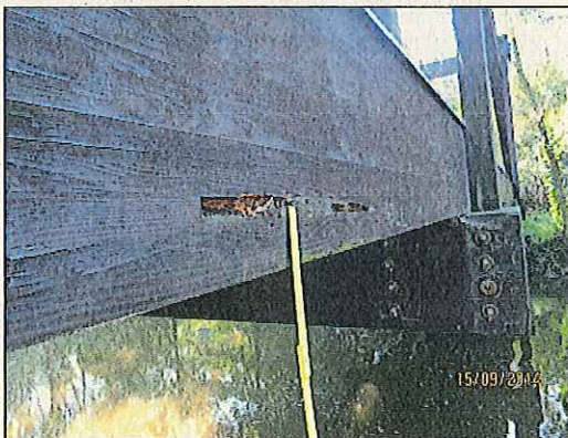
Abb. 34: Hängewerk, unten links, BSH gerissen Lamelle angefault
