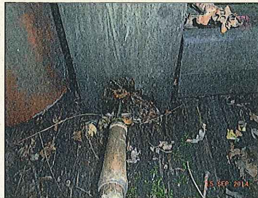
Abb. 27: Geländerpfosten oben angefault, morsch
