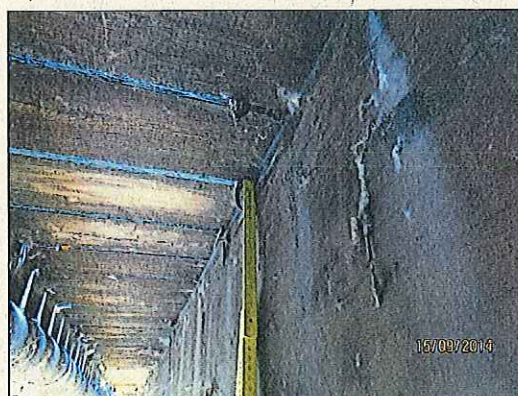
Abb. 46: Hängewerk, Längsträger, Abdichtung zu kurz ohne Überstand
