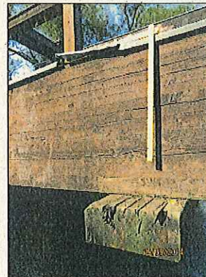
Abb. 35: Hängewerk, unten links, BSH gerissen Aussteifungsprofil angefault
