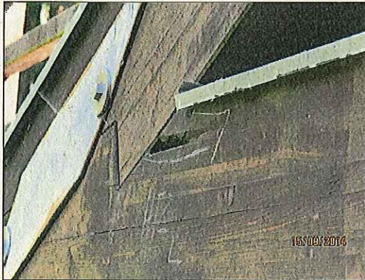
Abb. 36: Hängewerk, Konten hinten links BSH mit Innenfäule
