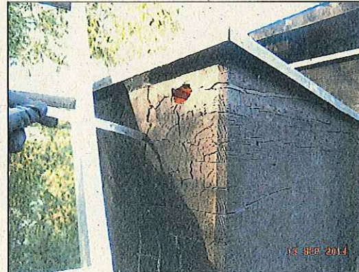
Abb. 33: Hängewerk, oben links, BSH Hirnholz gerissen & angefault
