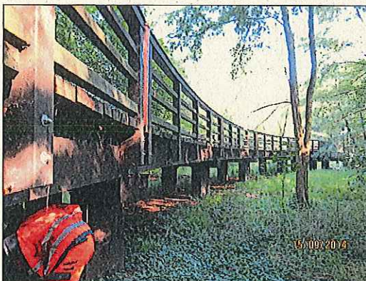
Abb. 04: Ansicht Vorlandbrücke Südwest
