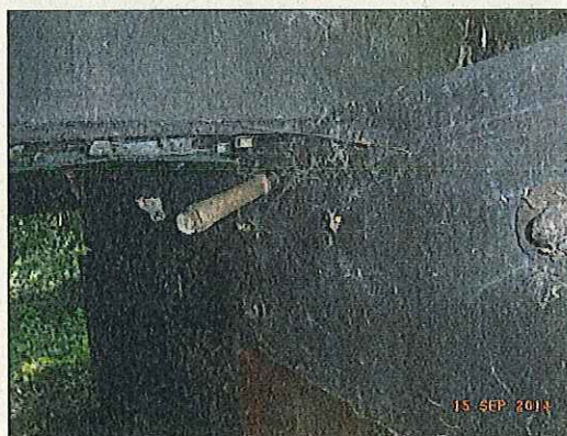
Abb. 22: Kopfbalken 8 Innenfäule
