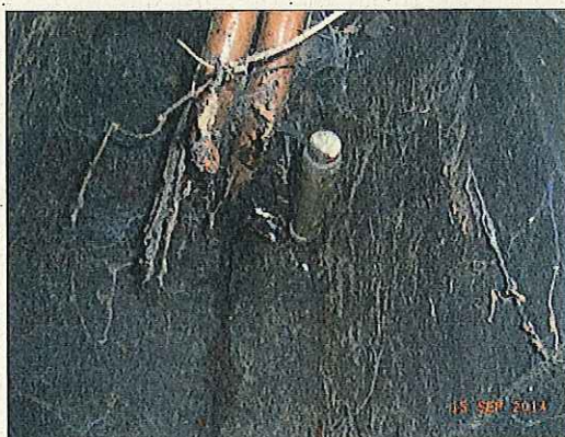
Abb. 08: Feld 3, BSH – Binder Stirnholz angefault & mit Myzelen
