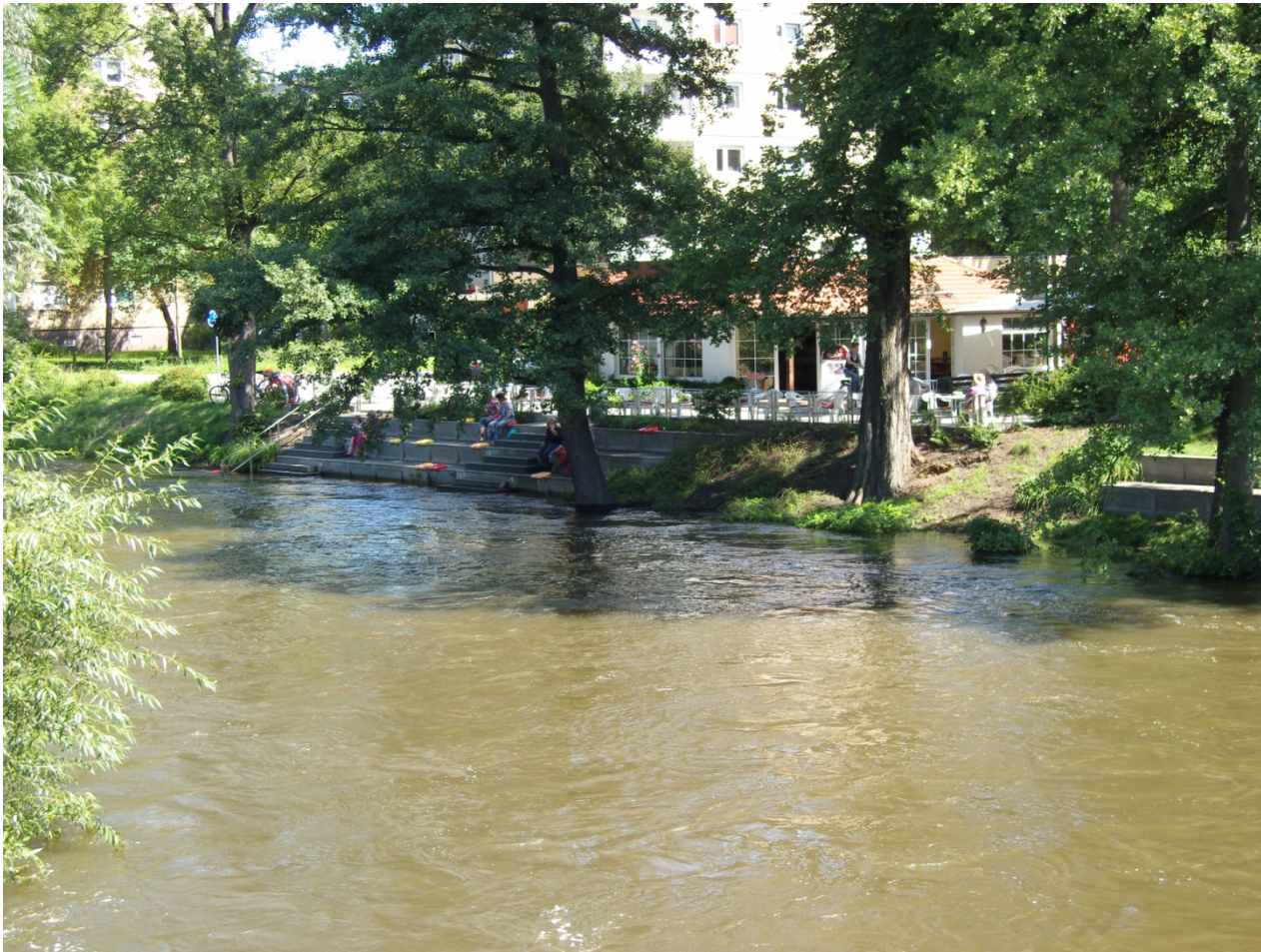
Spreehochwasser 2010, nahe der Sandower Brücke (am Pegel Sandow) -Spreehochwasser 2010-
