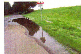
Auftreten von Sickerwasser
