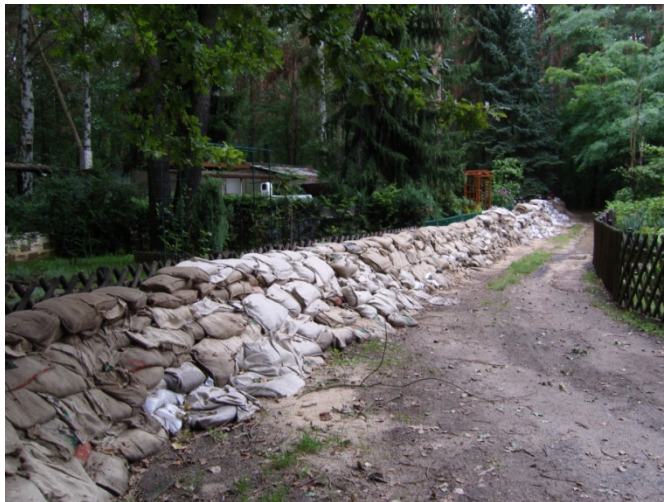
Sandsackverbau für das Luft und Waldbad in Kiekebusch
