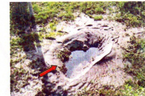
Qualmtrichter: Austritt von Wasser
