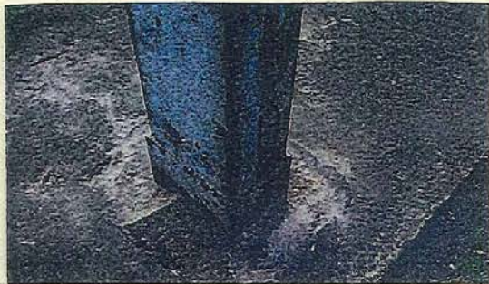
Verkehrszeichenbrücke Risse in der Betonoberfläche im Bereich der Einspannung /Stahlkonstruktion stark gerostet
