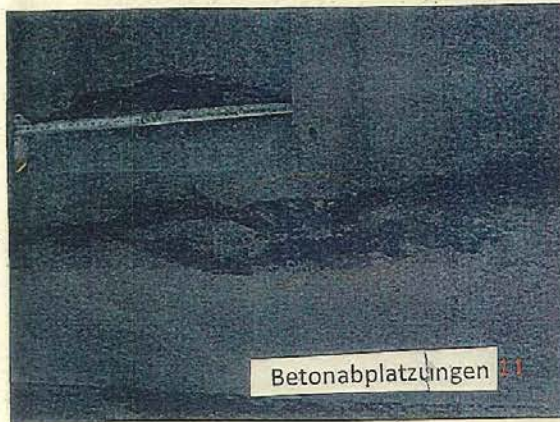
Verkehrszeichenbrücke Risse in der Betonoberfläche im Bereich der Einspannung /Stahlkonstruktion stark gerostet
