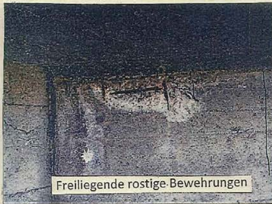
H.-Löns-Brücke Längsträger angefault
