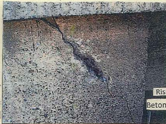
Verkehrszeichenbrücke Risse in der Betonoberfläche im Bereich der Einspannung /Stahlkonstruktion stark gerostet
