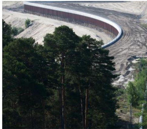
Die Kaimauer ist das erste Bauwerk für das neue Hafengebiet am Cottbuser Ostsee. Archivfoto: Michael Hebig © Foto: Michael Hebig
