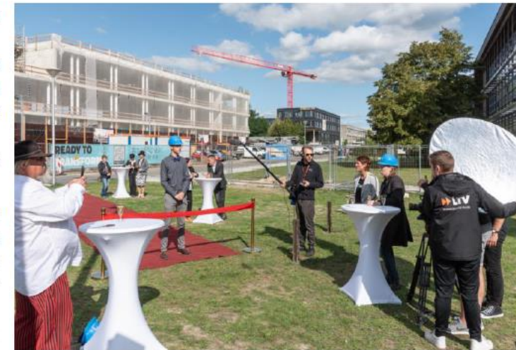
Im Hintergrund das ca. 5.500 qm große Gründungszentrum im Rohbau. Gemeinsam mit zahlreichen Mitwirkenden und mit Lausitz-TV unter der Regie von Erik Schiesko werden mehrere aufmerksamkeitsstarke Werbespots gedreht., Foto: EGC/ T. Goethe
