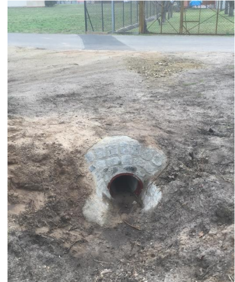
Umpflasterung des Einlaufes
