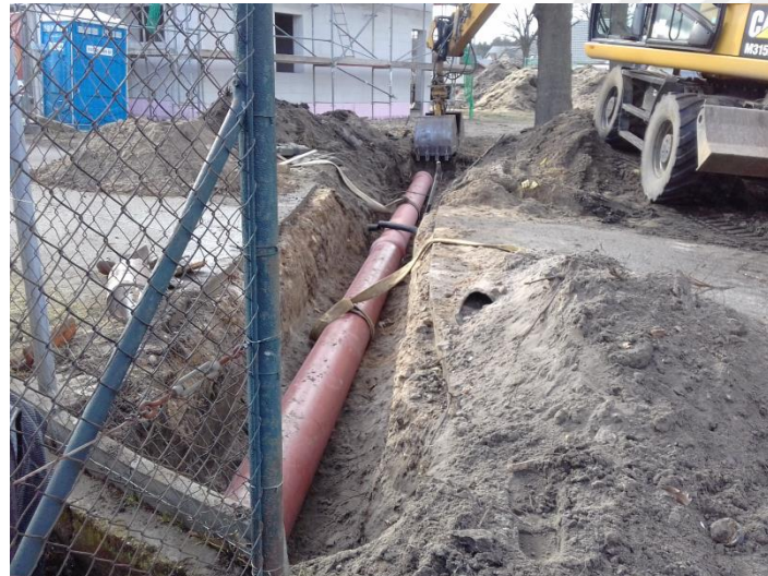
Einfädeln des neuen Rohres
