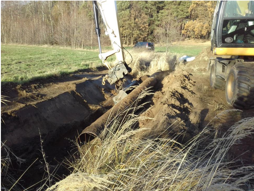
Rückbau altes Stahlrohr DN 300
