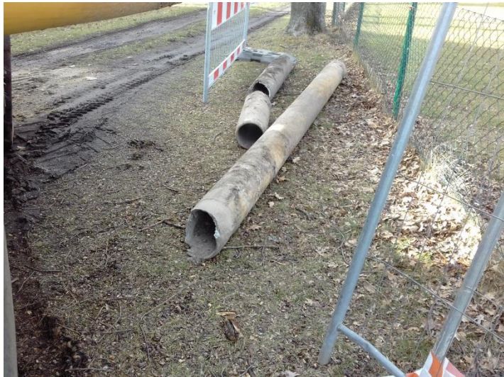
Zugesetztes altes Rohr
