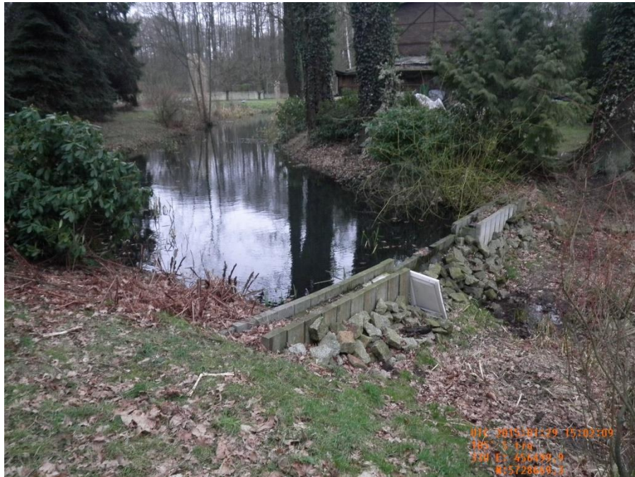
Staubauwerk Marke „Eigenbau“
