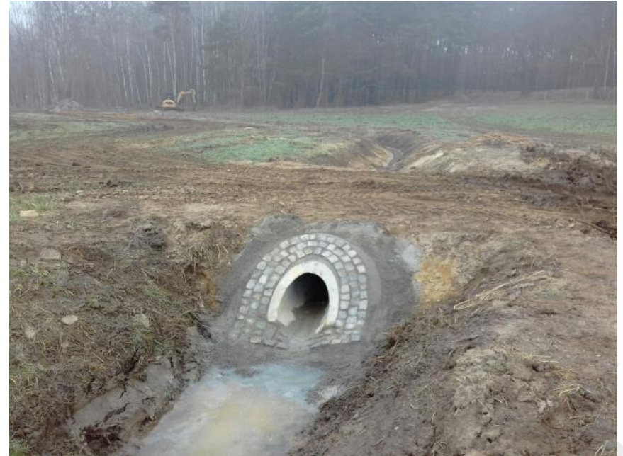
Einbau neues Betonrohr DN 500
