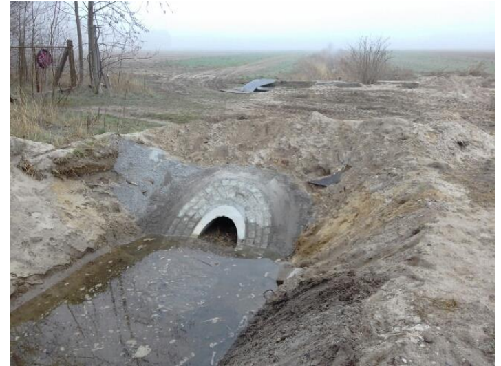
Umpflasterung des Auslaufs im Unterwasser
