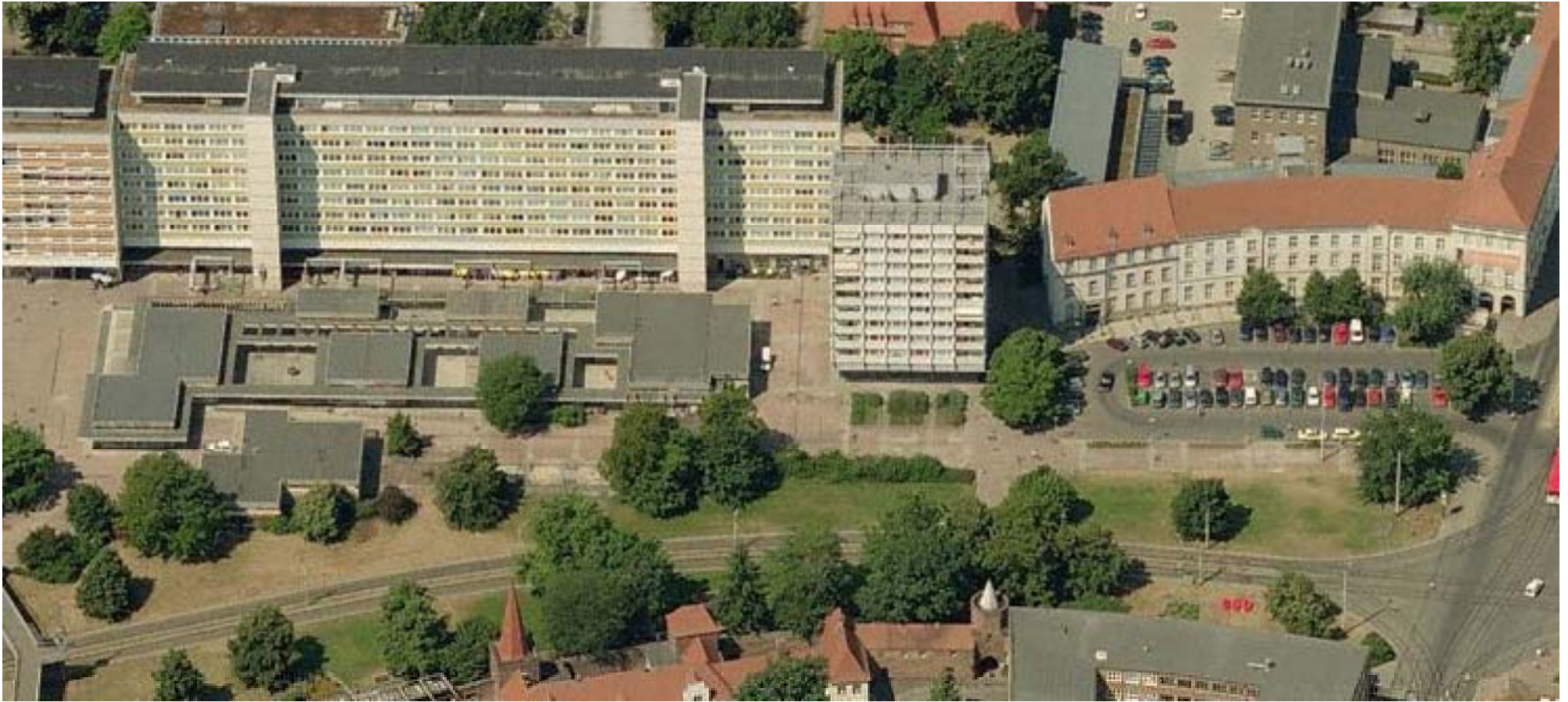
Bereich Pavillons, Blick von Osten (Quelle: http://maps.live.com )
