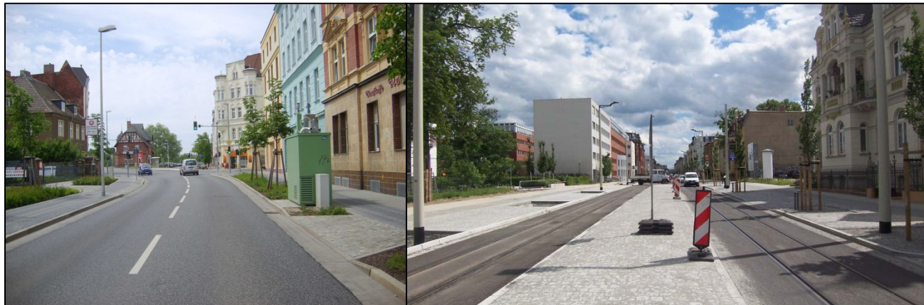
Schließung Mittlerer Ring Umgestaltung Bahnhofstraße
