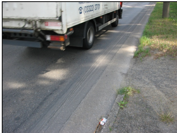
Sanierung von Fahrbahnoberflächen
