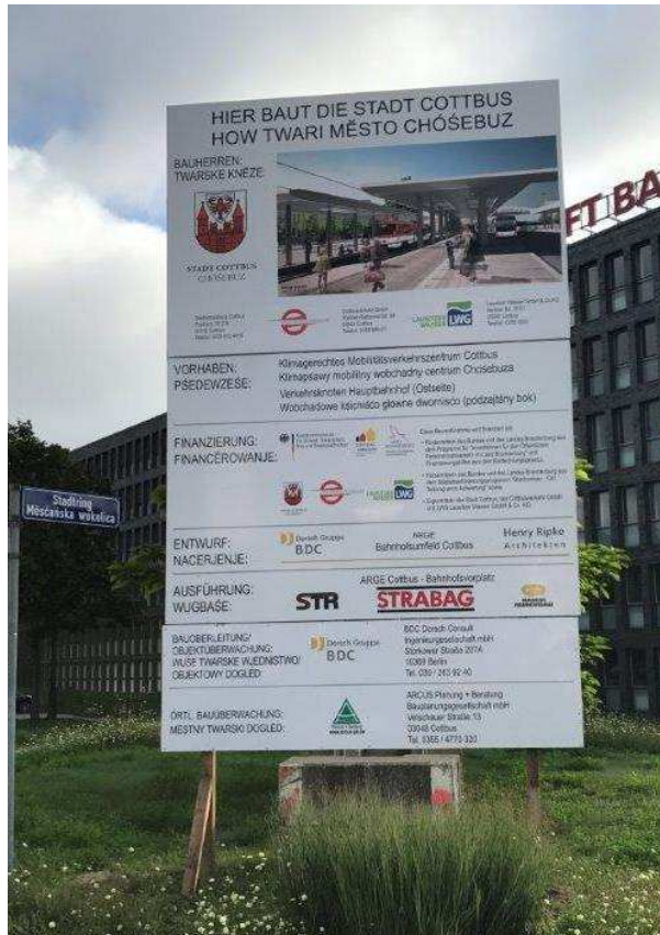
Zweisprachige Baustellenbeschilderung im Bahnhofsbereich der Stadt Cottbus/Chóšebuz
