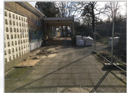
Bautenstand Kita Wehrpromenade
