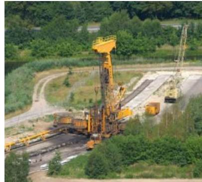
1993 - 2007: Errichtung der Dichtwand
