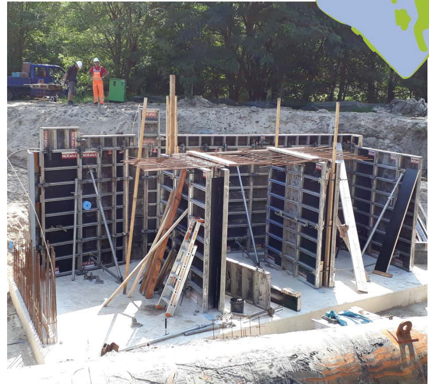
Schalungsarbeiten Abschlagsbauwerk Hammergraben
