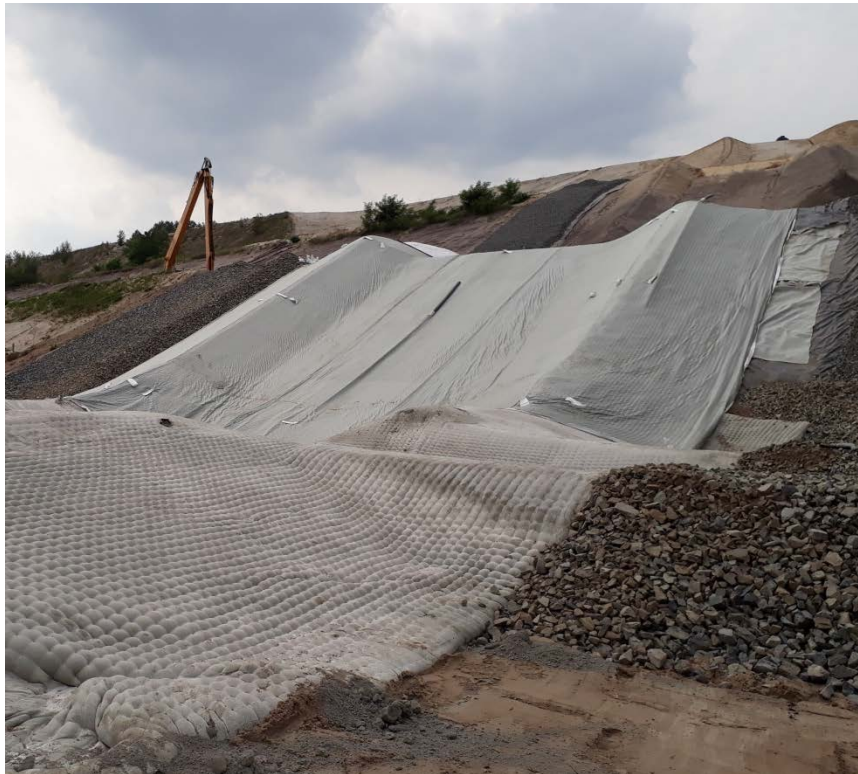
Verlegung Incomat®-Matten temporäres Einlaufbauwerk
