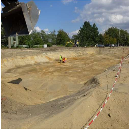
Verdichten Fundamentsohle
