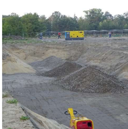
Verdichtungsarbeiten Bereich BHKW
