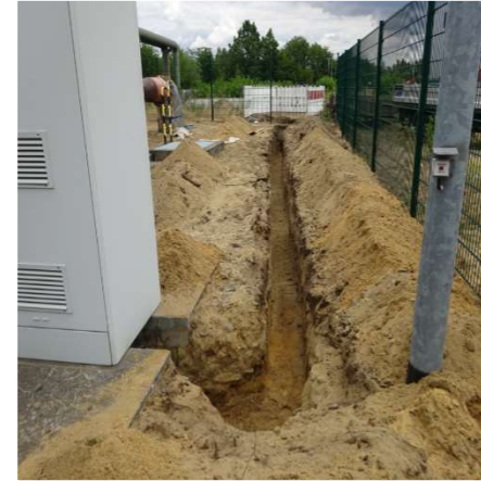
Erdarbeiten Freilegen Kabel
