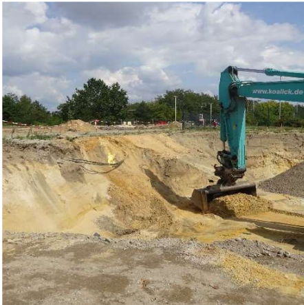
Aushubarbeiten BHKW- Baugrube
