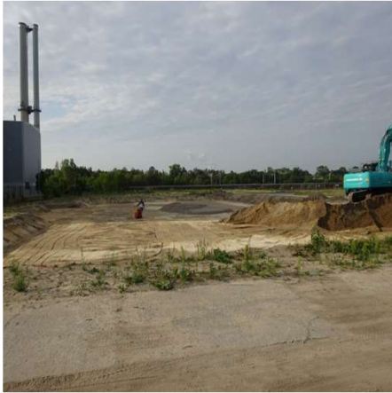
Aushubarbeiten BHKW- Baugrube
