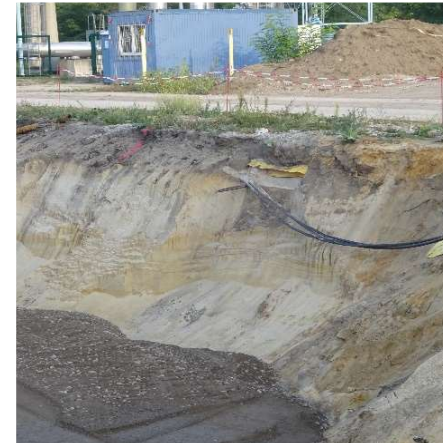
Freigelegtes 20kV-EVC Mittelspannungskabel
