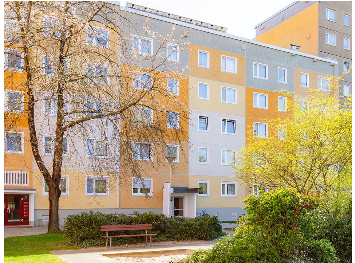
Hüfnerstraße 62-68 Fassadeninstandsetzung und Anbau neuer Balkone
