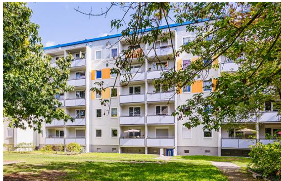
Ewald-Müller-Straße 16-18 Fassaden- und Balkoninstandsetzungen
