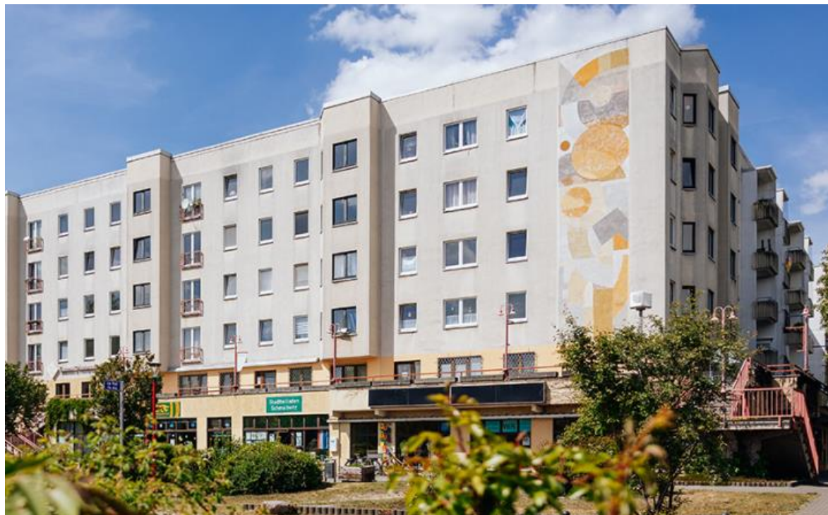
Baubeginn Zuschka 25-33 und 34-39
