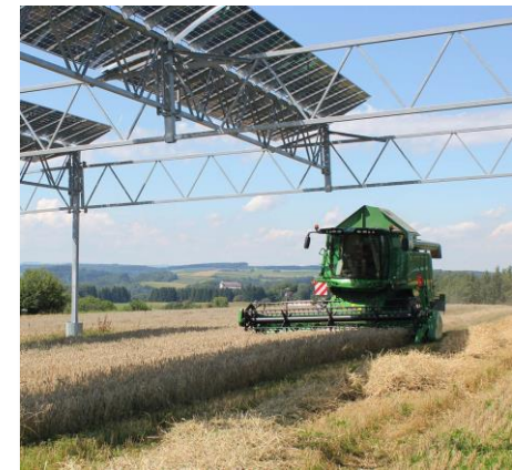
Agri-Photovoltaik-Anlage © Hofgemeinschaft Heggelbach
