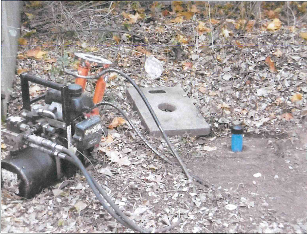
Foto 25: Im Bohrloch KRB 2 bis 7,00 m eingebauter Rammpegel P 1
