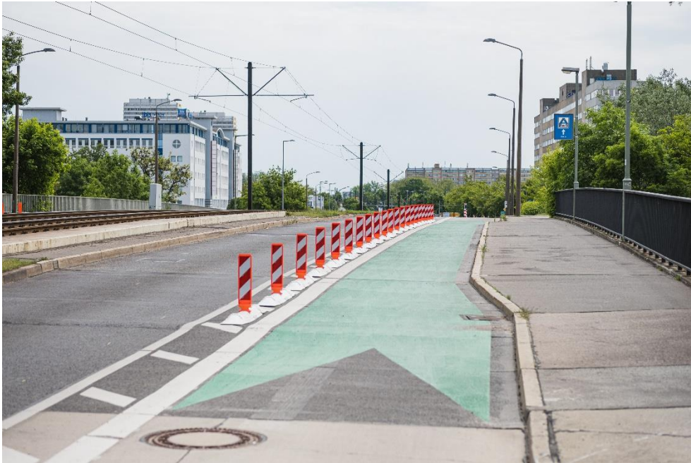
Abbildung 10: Geschützter Radfahrstreifen in Berlin. Verhältnismäßig schnell umsetzbare Maßnahmen fördern an Straßen mit Überkapazitäten Sicherheit und Sichtbarkeit des Radverkehrs im Straßenraum. (Foto: IGS)
