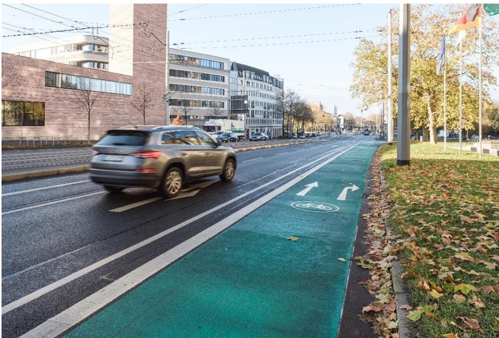
Abbildung 7: Markierungslösungen (Schutzstreifen, Radfahrstreifen u.a.) bieten kostengünstige, sichere und schnell umsetzbare Verbesserungen für den Radverkehr bei ausreichenden Querschnittsbreiten (Beispiel Leipzig, Foto: IGS)
