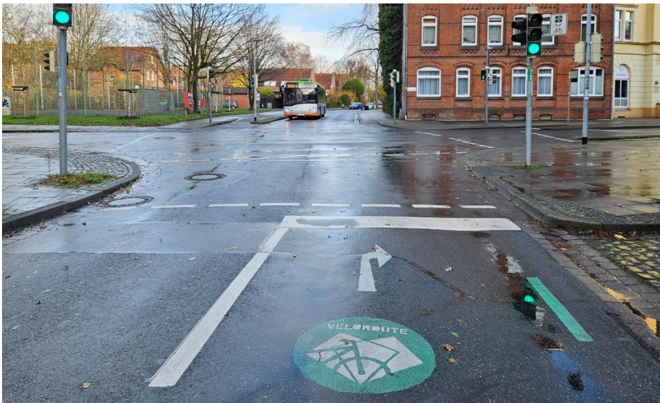
Abbildung 27: Kennzeichnung der abbiegenden Veloroute an einem Knotenpunkt. Die Wegweisung ist auch am Ampelmast angebracht. Die Abbiegebeziehung ist zusätzlich Verkehrszeichen 721 "Grünpfeilschild mit Beschränkung auf den Radverkehr" ausgestattet (Quelle: IGS).
