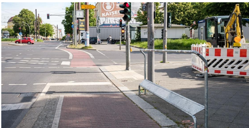
Abbildung 50: Haltegeländer mit Fußstütze in Berlin. Einfache Maßnahme zur Komfortsteigerung und Imagepflege (Quelle: IGS)
