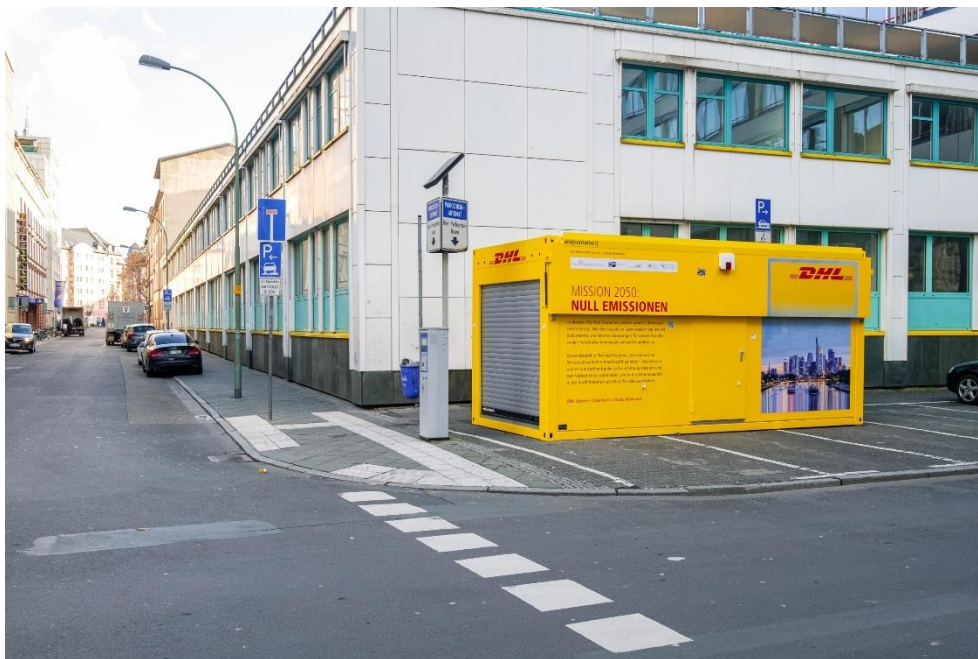
Abbildung 53: Micro-Hub-Beispiel - Häufig werden zunächst Standorte getestet im Rahmen von Pilotprojekten. Einfache Umsetzung im Bestand mit Container-Lösungen (Quelle: IGS)
