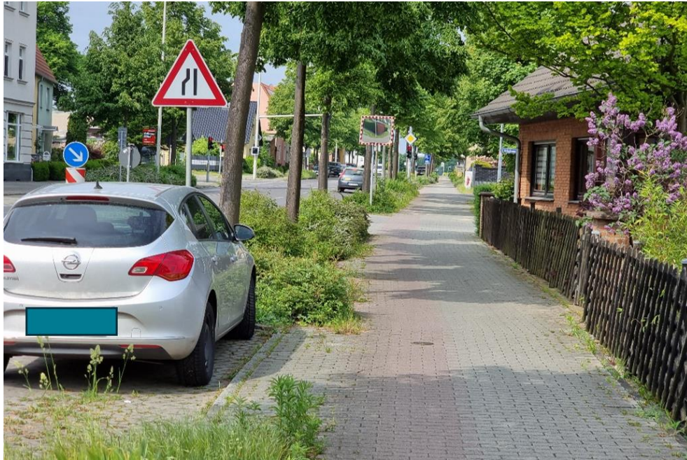
Abbildung 19: Benutzungspflichtiger nicht regelwerkskonformer getr. Geh-/Radweg in der Kolkwitzer Straße (zu schmal, fehlende Bodenindikatoren, schlechte Sichtverhältnisse an Einmündungen) (Quelle: IGS)
