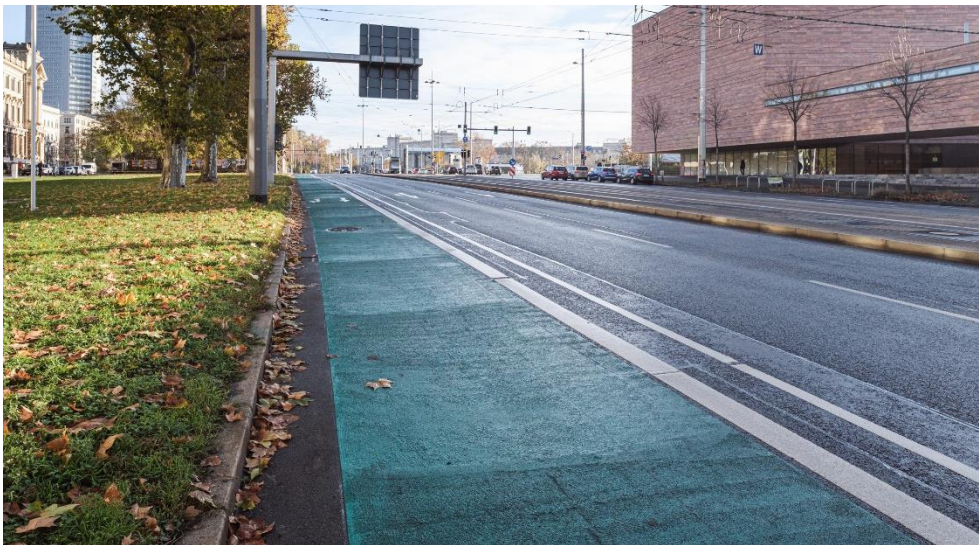
Abbildung 37: Breiter Radfahrstreifen mit Doppelinientrennung (Bsp. Leipzig, Quelle: eigenes Bild)
