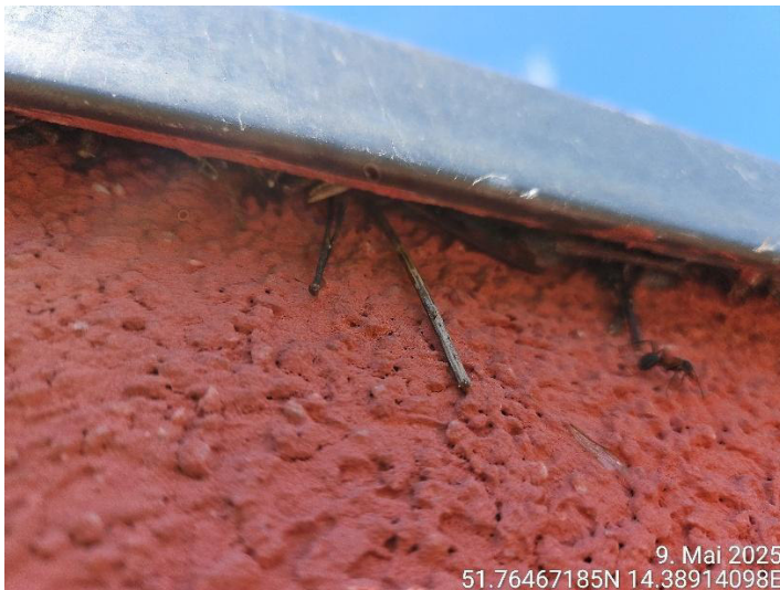
Abbildung 33: Nistmaterialtransport unter Attikaverblechung (Quelle: BAGU, 2025)
