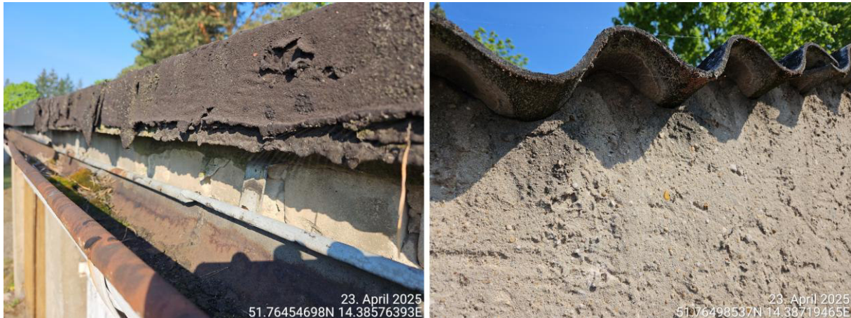
Abbildung 8: Exemplarische Aufnahme der bündig abschließenden Dacheindeckungen (Quelle: BAGU, 2025)
