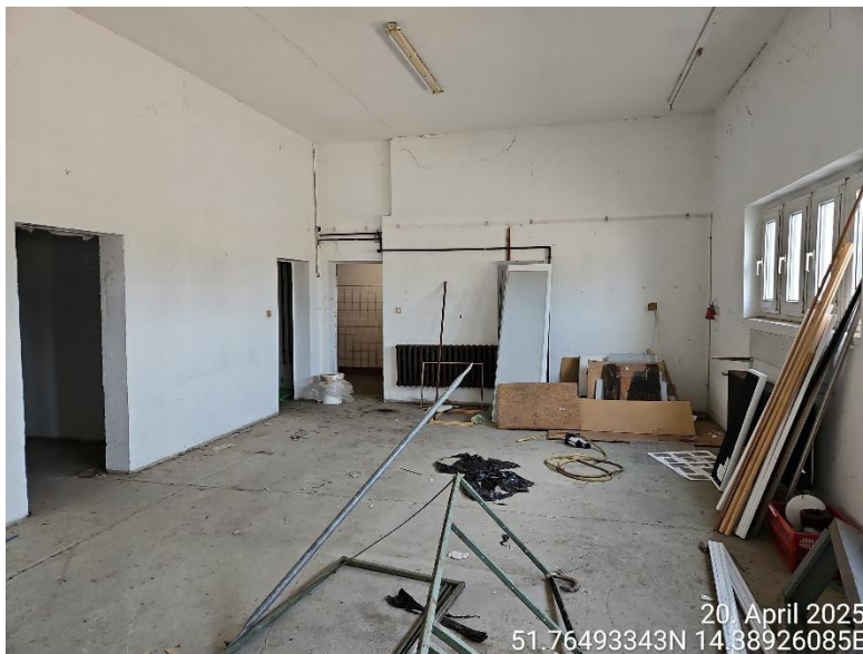
Abbildung 20: Blick in das Teilobjekt „2“ (Quelle: BAGU, 2025)
