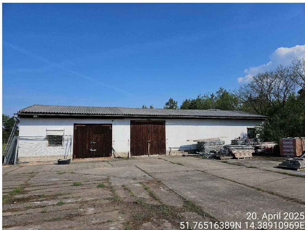
Abbildung 16: Blick auf die Lagerhalle von Süden aus (Quelle: BAGU, 2025)
