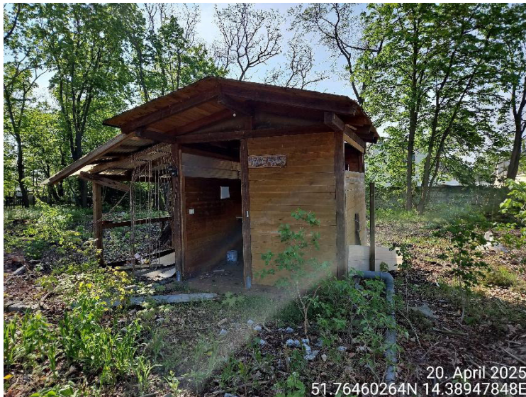
Abbildung 23: Blick auf die „Outdoor-Sanitäreinrichtung“ von Norden aus (Quelle: BAGU, 2025)
