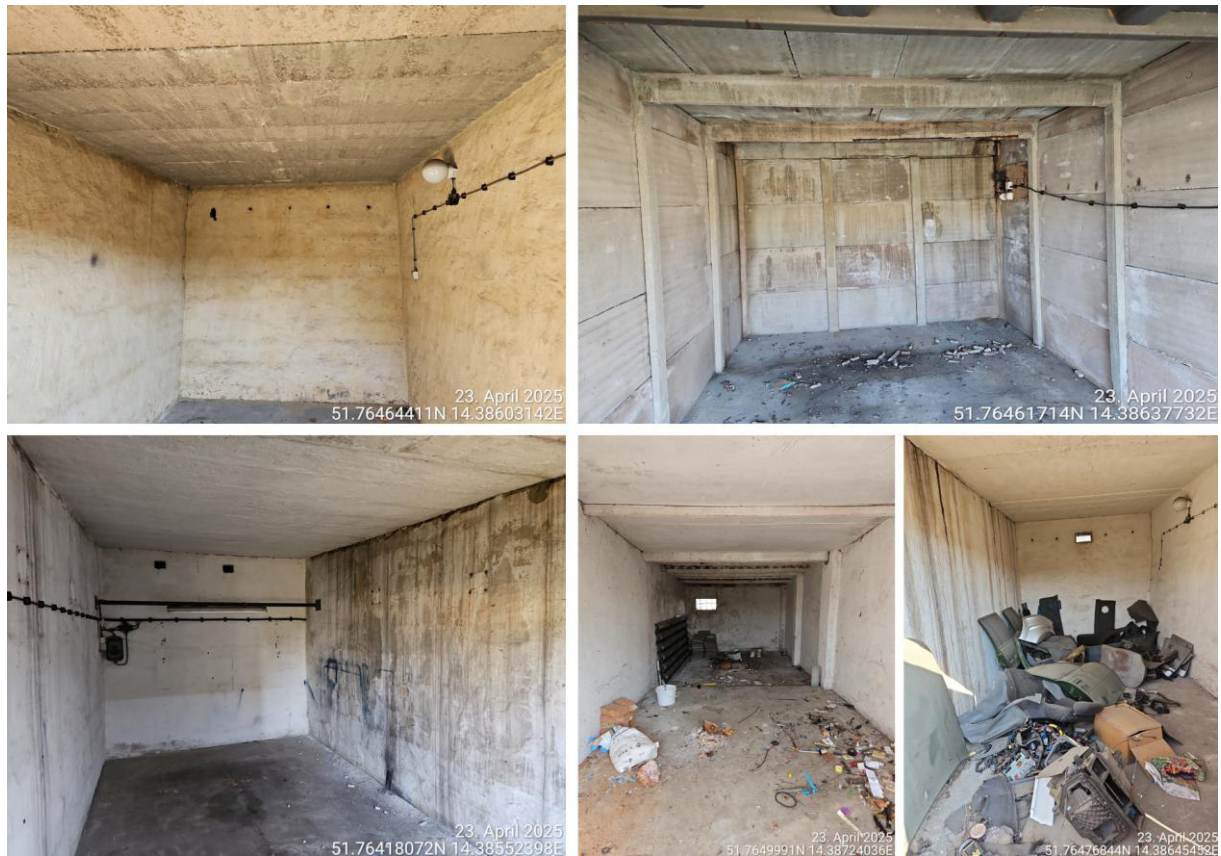
Abbildung 6: Ansicht von exemplarischen Garageninnenräumen (Quelle: BAGU, 2025)
