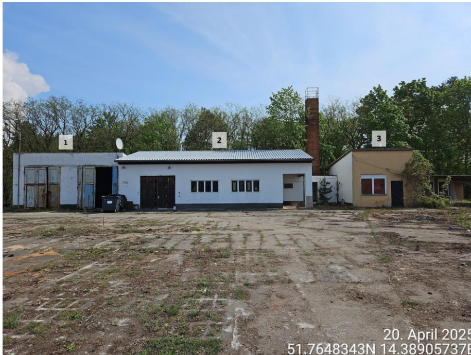
Abbildung 18: Blick auf das „Werkstattgebäude mit Anbauten“ von Westen aus (Quelle: BAGU, 2025)
