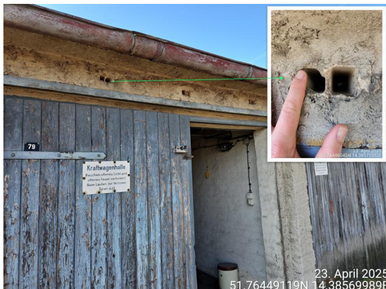
Abbildung 3: Detailaufnahme von faunistisch relevanten Lüftungsöffnungen, exemplarisch bei der Garage Nr. 79 (Quelle: BAGU, 2025)
