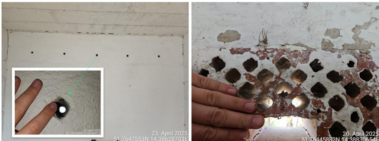
Abbildung 5: Weitere Lüftungsöffnungen mit faunistischer Relevanz (v.a. Fledermäuse; Pipistrellus spec.; sowie Nischenbrüter beim rechten Bild) (Quelle: BAGU, 2025)
