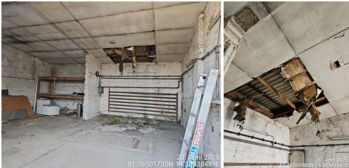
Abbildung 19: Blick in den Werkstattbereich sowie Detailansicht auf Dachzwischenraum (Quelle: BAGU, 2025)
