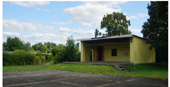
12. Viele Infrastrukturen in den Kleingartenanlagen sind veraltet
