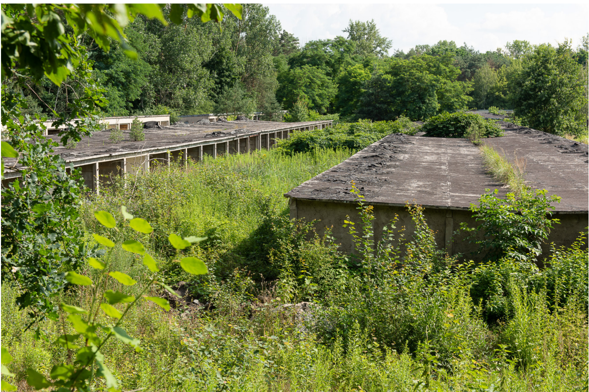
Blick vom Nordrand der Vorhabensfläche nach Süden über die mit Vegetation überwucherten Garagenkomplexe
