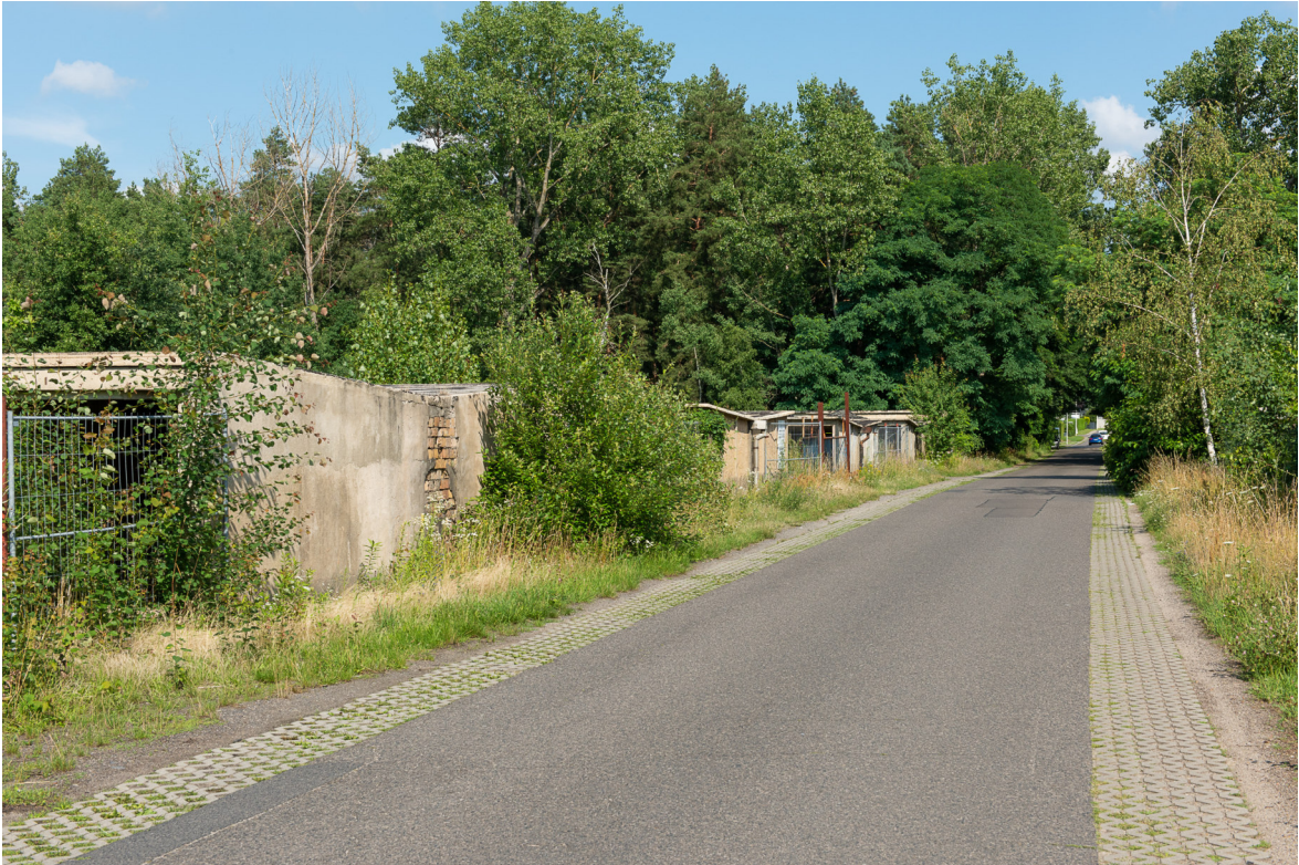
Blick vom Westrand der Vorhabensfläche nach Osten entlang der Grenzstraße; links sind Teile der nördlichen Garagenkomplexe zu erkennen. (Juli 2021)
