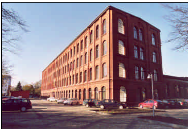
Umgenutztes Fabrikgebäude an der Parzellenstraße
