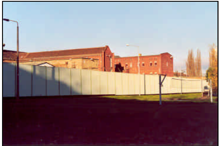
Außenbereich im Süden
