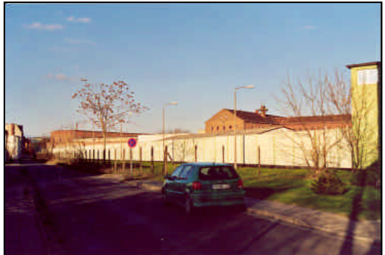
Außenbereich im Osten an der Gartenstraße
