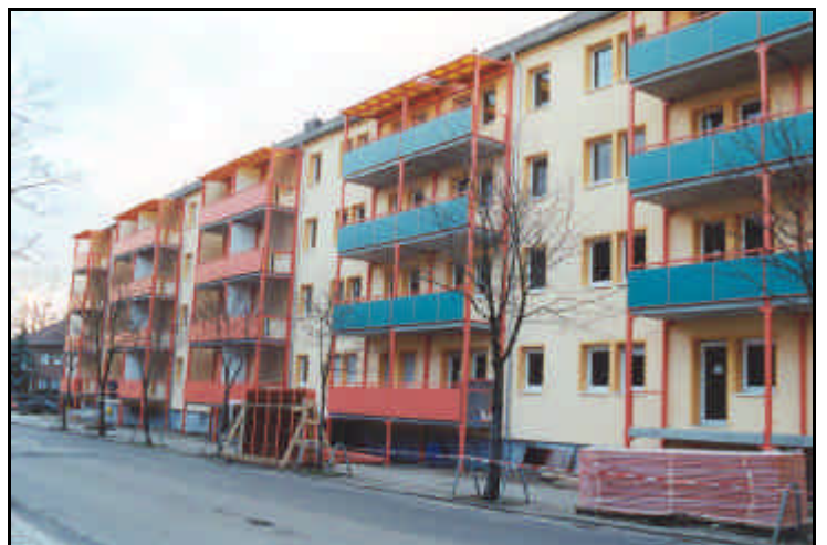
Modernisierungs- und Instandsetzungsmaß- nahmen an der Eilenbur- ger Straße
