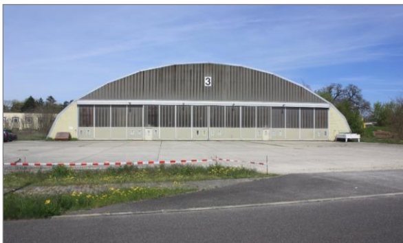
Abbildung 2.14: Luftfahrzeughalle (Gebäude Nr. 23)
