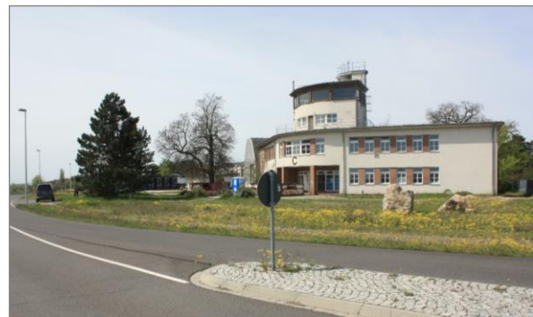
Abbildung 2.15: Befehlsstelle (Gebäude Nr. 24)
