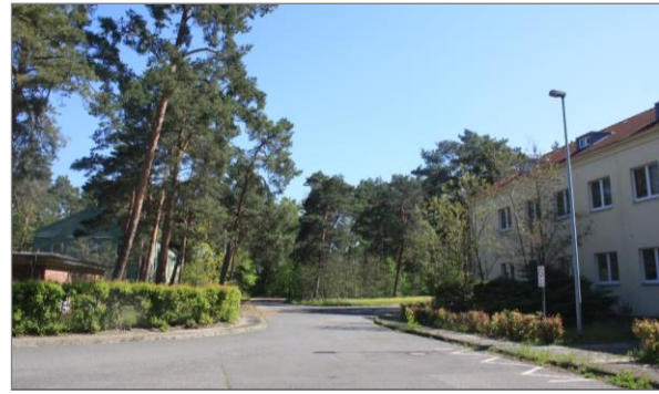
Abbildung 2.13: Bauten der Erweiterung des Fliegerhorstes (Gebäude Nr. 14, 17 - rechts im Bild)
