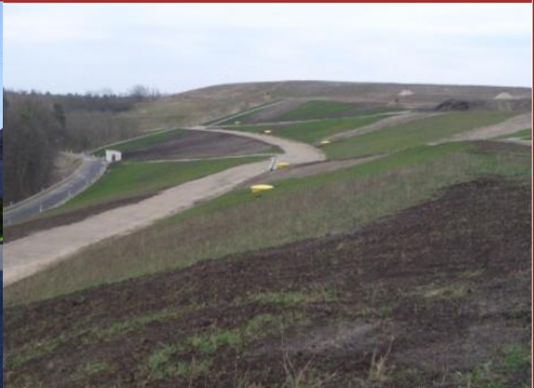
77 Stillgelegte Deponie, stellvertretend für Belastungen im Landschaftsraum
