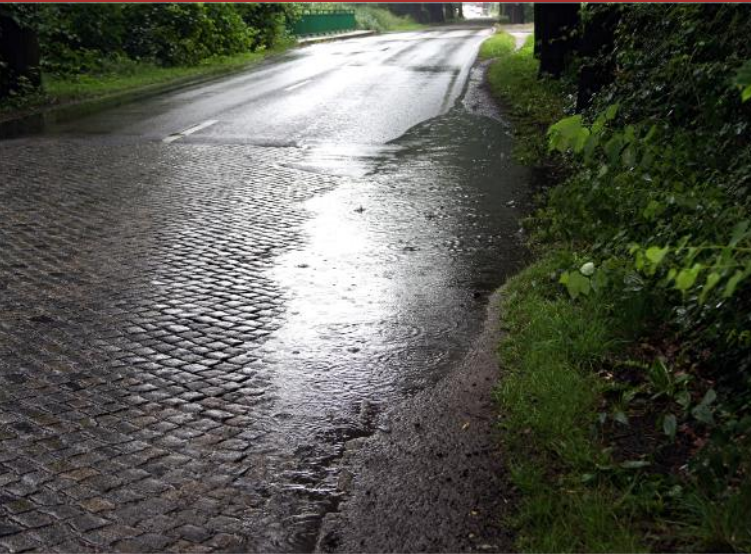
66 Straßenzustand und Gestaltung auf der Bahnhofstraße
