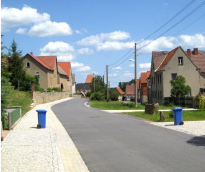
119 Ausbau und Neugestaltung eines Straßenraums (Walperhain)
