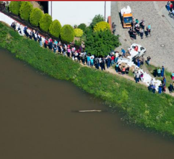
Hochwasserschutzmaßnahmen im Jahr 2013 28
