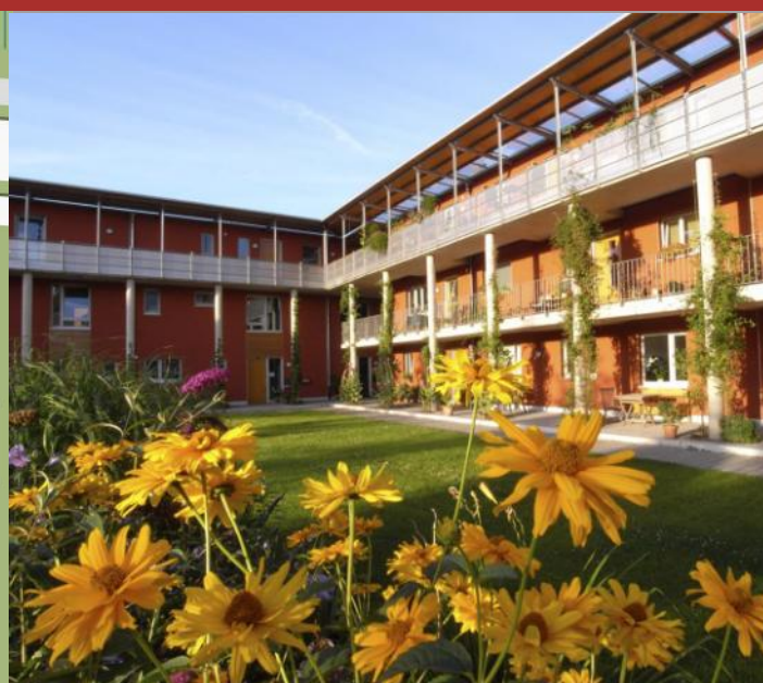
140 Mehrgenerationenwohnen am Tremoniapark in Dortmund
