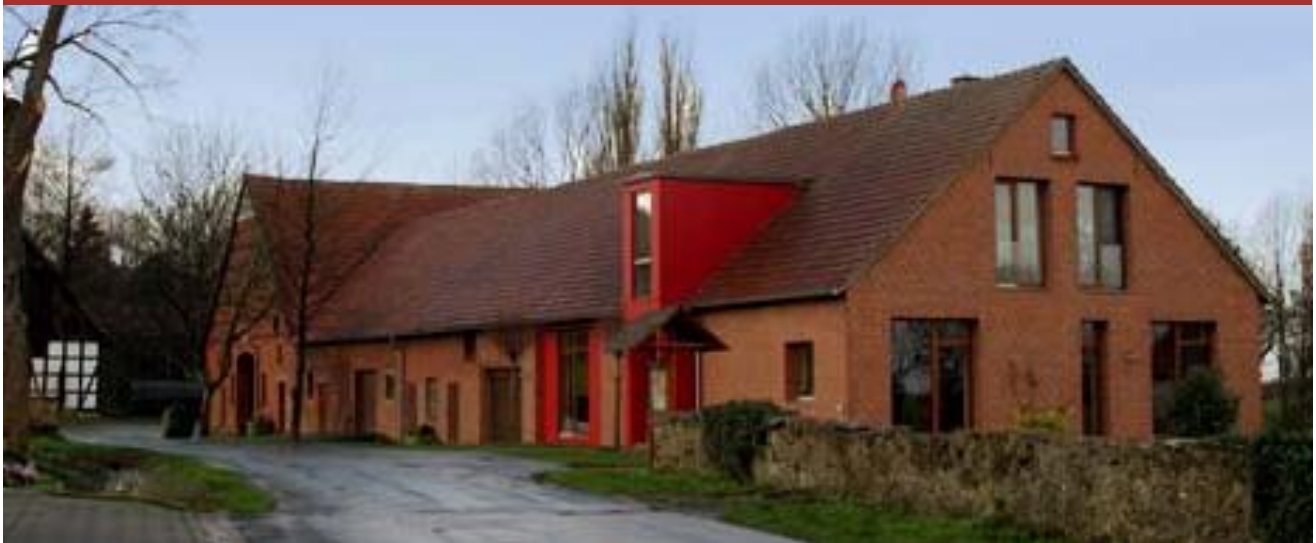
137 Beispiel für den Umbau einer Scheune zu Gunsten einer Wohnnutzung in Hille
