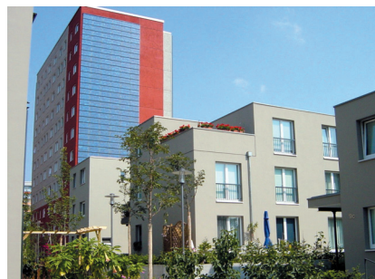
Platte wird Stadthaus – ein Leuchtturmprojekt: Bau von Stadtvillen aus gewonnenen Plattenelementen eines demontierten 11-geschossigen Wohnhochhauses
