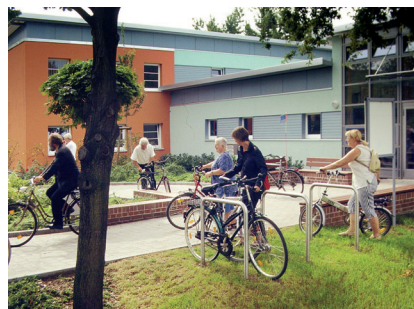
Eine leergefallene Kita wurde zum Nachbarschaftszentrum umgebaut
